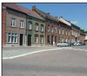
Figure 394 : Photographie, rue du Pont
