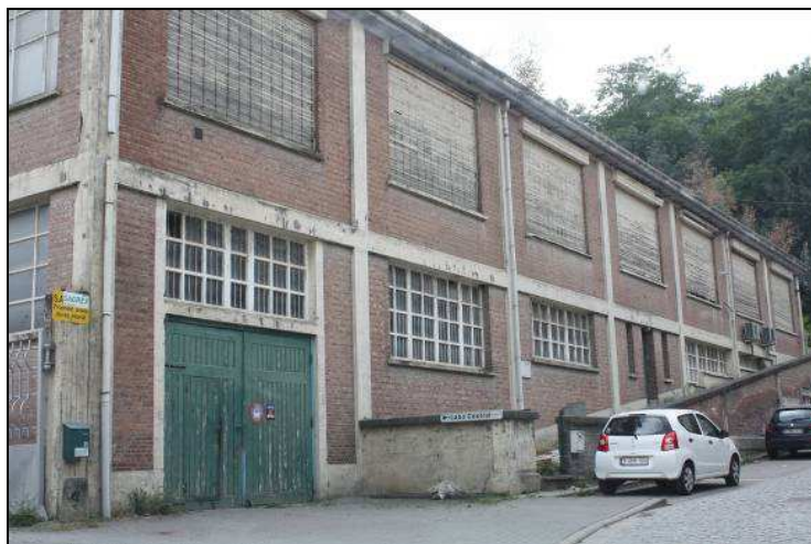
Figure 371 : Photographie, bâtiment lié à l'exploitation de porphyre (Source : Agora, 2011)
