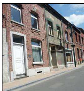
Figure 390 : Photographie, rue du Pont
