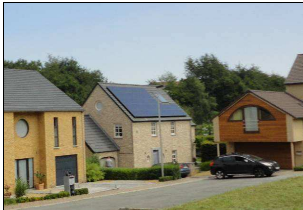
Figure 455 : Photographie d'une toiture disposant d'un système de panneaux photovoltaïques
