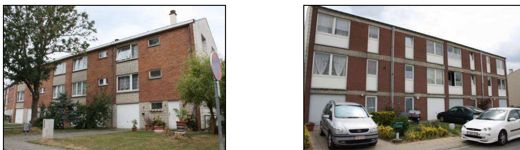
Figure 447 : Photographies de logements publics à la Cité des Agaces, à Quenast
